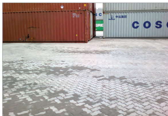
Состояние дорожных покрытий в зоне подпятников контейнеров через 2 года после начала эксплуатации.
