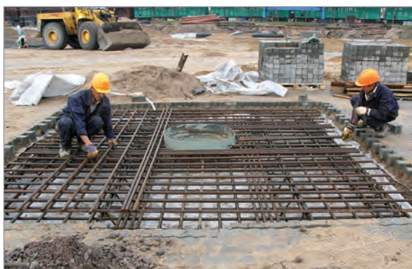
Устройство колодцев ливневой канализации
