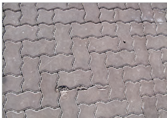
Скалывание углов некоторых камней мощения – редкий дефект покрытия. Возможные причины: 1) выступ камня над общим уровнем покрытия; 2) значительная сосредоточенная нагрузка на покрытие (металлические предметы и т. п.).
