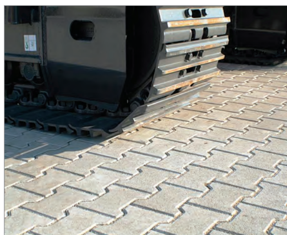
Рис. 3.8. Мощение на площадке завода производителя строительных машин и оборудования "Kraemer Baumaschinen" обеспечивает движение техники на гусеницах с грунтозацепами. Мощение выполнено в 2011 году на площади 2 000 кв.м. (фото с сайта www.korodur.de ).
