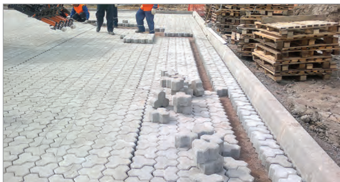
Рис. 3.18. Исправление дефектов мощения, вызванных несоблюдением прямого угла пересечения продольных и поперечных рядов.
