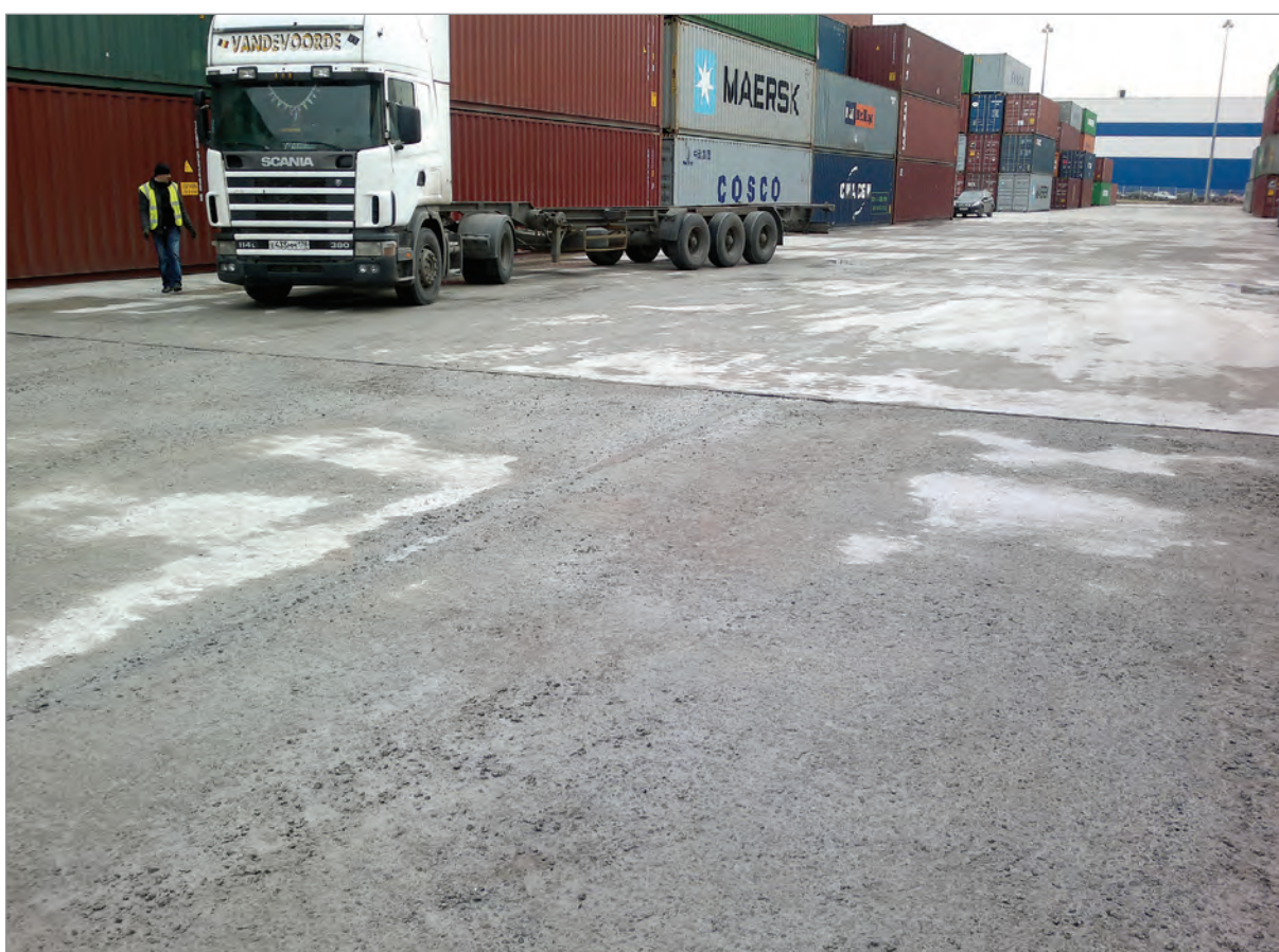
Рис.2.6. Шелушение монолитных железобетонных покрытий.
