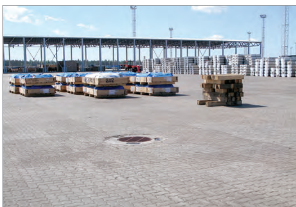
Общий вид покрытия. Виден уклон покрытия в сторону водосборного колодца.
