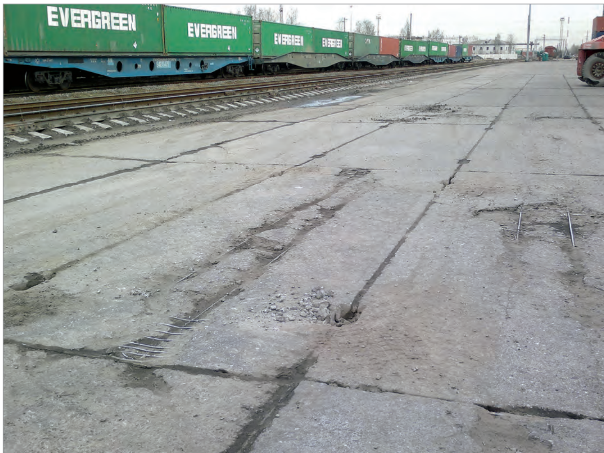
Рис. 2.5. Разрушение покрытия из сборных железобетонных плит.
