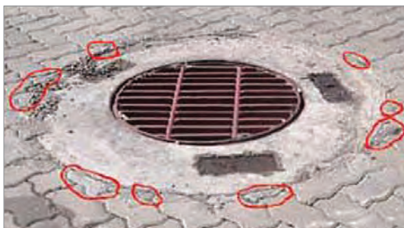
Рис. 3.23. Неправильное выполнение примыкания мощения к колодцу. Много мелких доборных элементов
