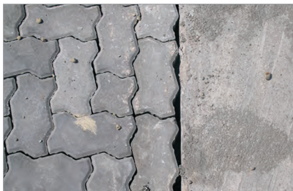
Примыкание мощения к монолитному железобетонному покрытию
