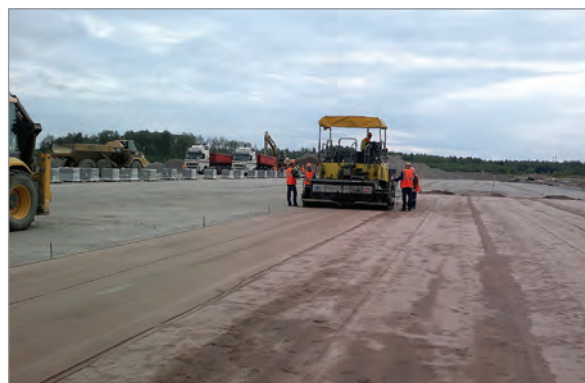
Слои основания дорожной одежды Устройство выравнивающего (монтажного) слоя из гранитного отсева механизированным способом
