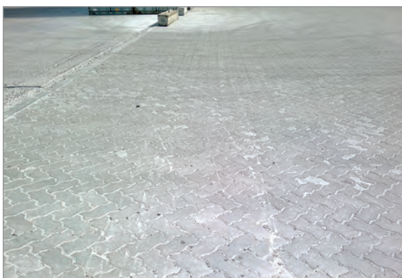
Шелушение лицевой поверхности камня. Причина – мелкие щебенки, которые заносились на покрытие с примыкающего разрушающегося участка монолитного покрытия.
