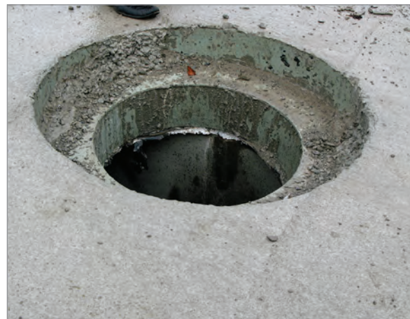
Рис. 3.26. Устройство монолитной железобетонной плиты в зоне колодца.
