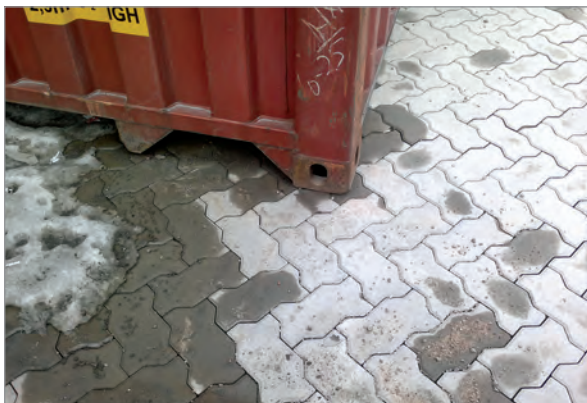
Состояние дорожных покрытий в зоне подпятников контейнеров через 2 года после начала эксплуатации.
