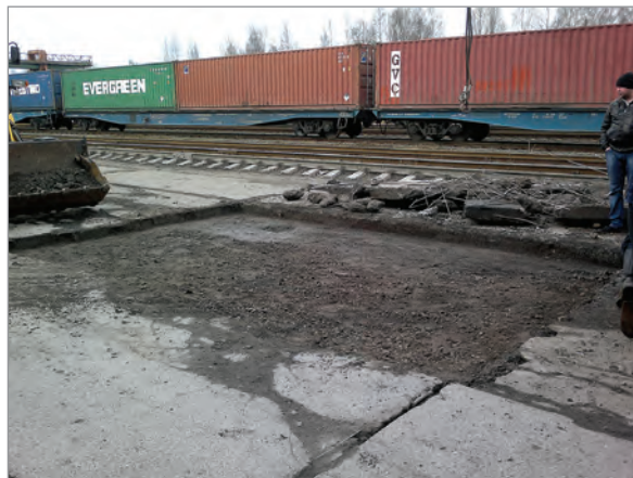
Вскрытие дорожного покрытия из плит ПАГ и подсыпка основания мелким щебнем
