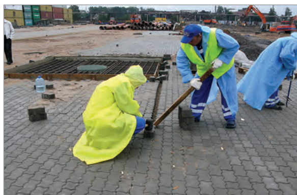
Исправление дефектов укладки
