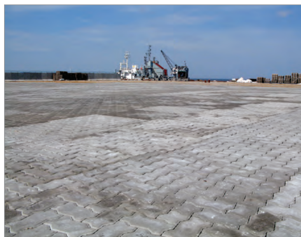
Дорожное покрытие из камней мощения характеризуется большой протяженностью швов, которые должны быть тщательно заполнены
