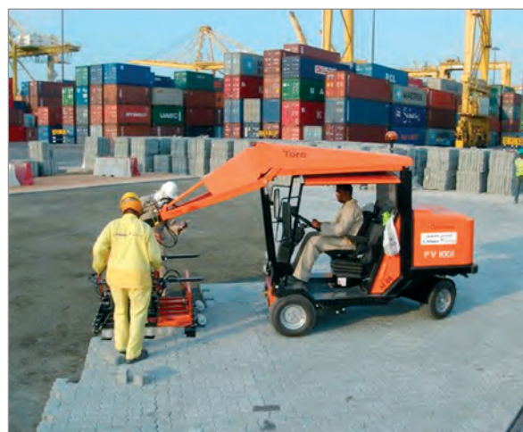
Рис. 5. 1. Мощение территории порта. Раскладка камней под углом 45^\circ к оси проезда .
