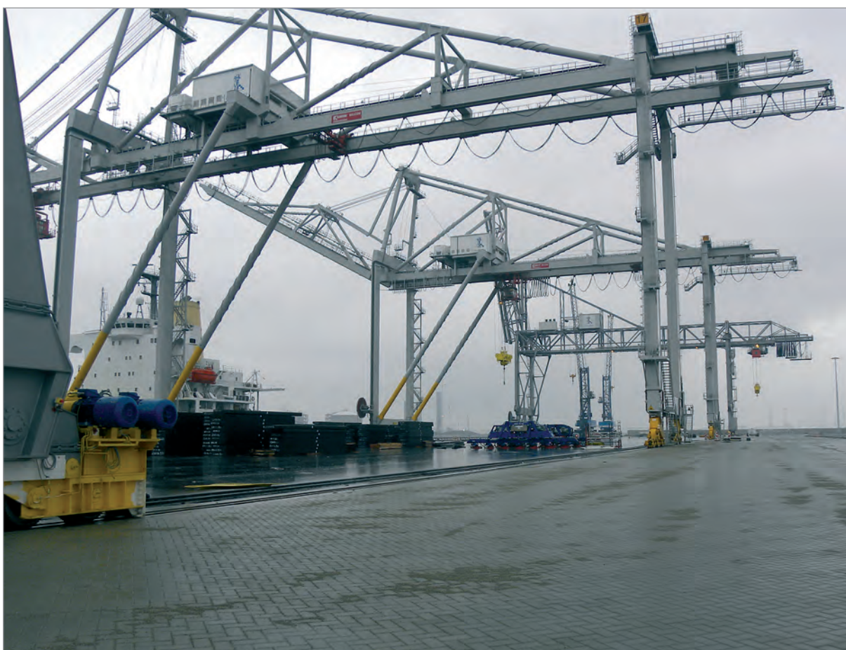
Рис.3.3 Терминал Бременской логистической группы ("БЛГ Логистик"), г. Бремен (Германия). Время эксплуатации мощения – 30 лет.
