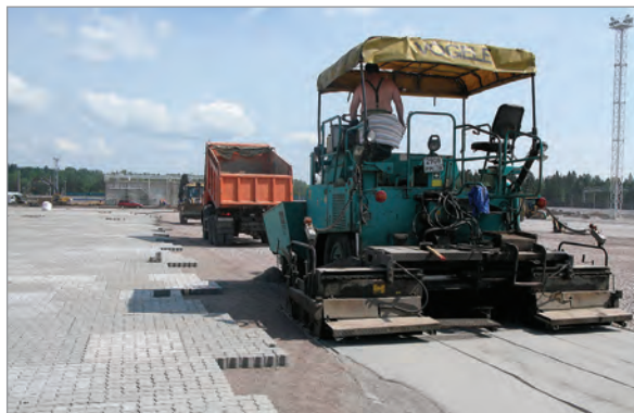
Устройство монтажного слоя асфальтоукладчиком
