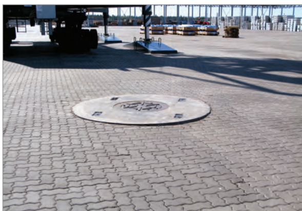
Дефекты покрытия – местные деформации около некоторых колодцев были устранены в рамках гарантийных обязательств.
