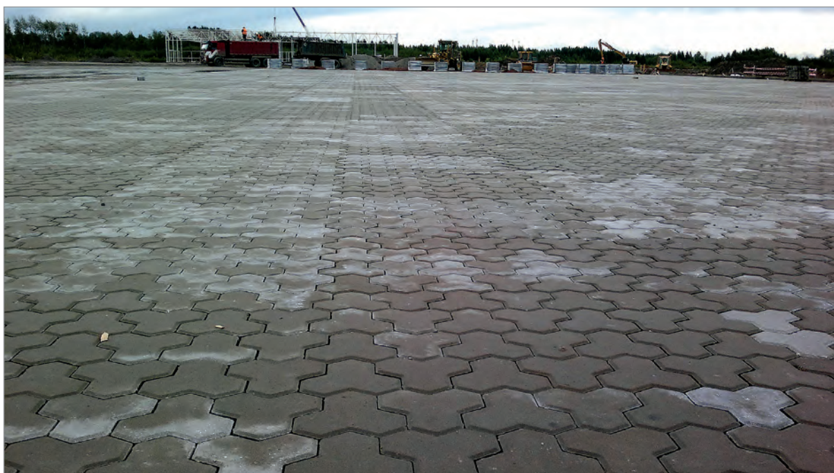
Рис.2.3. Пример раскладки в дорожном покрытии камней 4.Ф10 "Трилистник".
