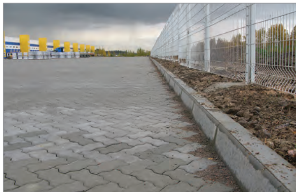
Закрепление краев мощения с помощью полимерного материала
