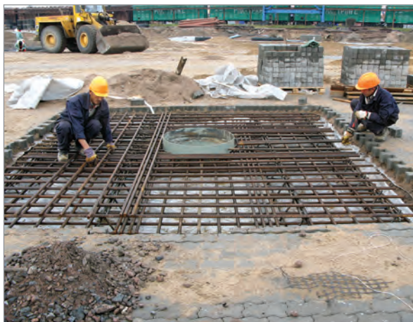
Рис. 3.26. Устройство монолитной железобетонной плиты в зоне колодца.
