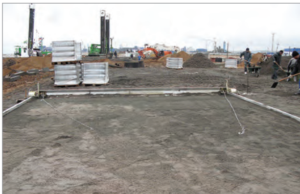
Применение телескопического рубанка фирмы "PROBST" для подготовки основания
