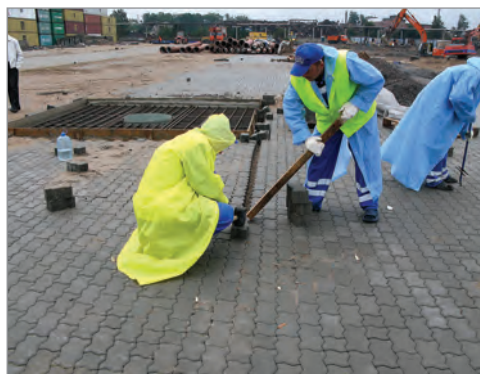
Рис. 3.18. Исправление дефектов мощения, вызванных несоблюдением прямого угла пересечения продольных и поперечных рядов.
