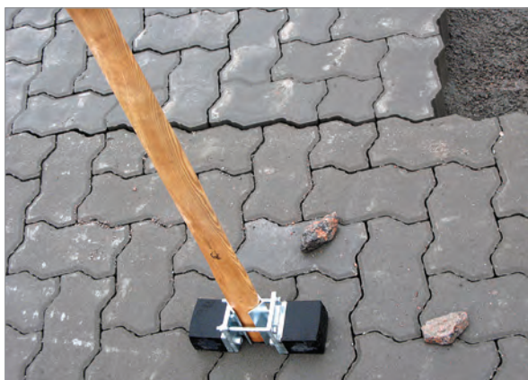
Рис.3.20. Резиновый молоток для выравнивания уложенных рядов.
