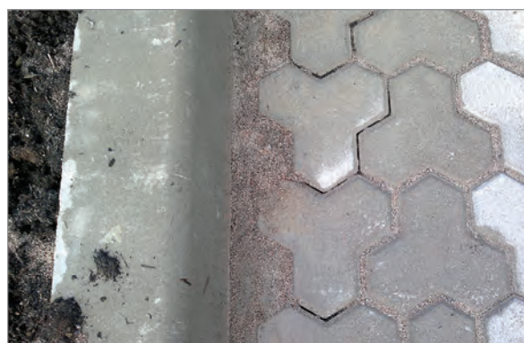
Закрепление краев мощения с применением полимерного состава
