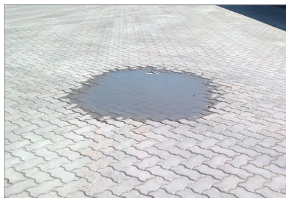
Местная деформация покрытия. На начальном этапе – легко устранимый дефект.
