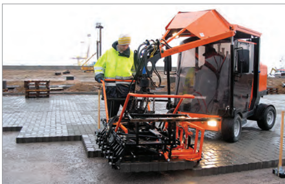
Процесс укладки камней с помощью машины "OPTIMAS"
